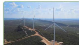
巴西东北部皮奥伊州 LDB 风电扩建项目，首次将中国成熟的风机设备引进巴西，是中广核在巴西首个自主工程建设和管理的绿地风电项目。
