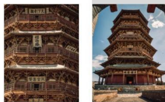
应县木塔是现存最古老最高大的木塔，与法国埃菲尔铁塔、罗马的比萨斜塔称为世界三大奇塔。
